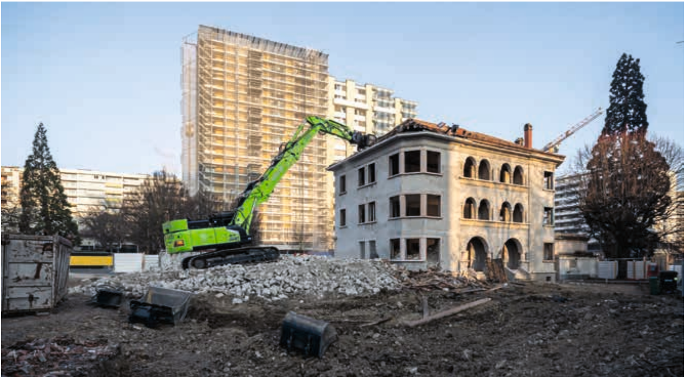
DÉBUT DU CHANTIER DE L'IMMEUBLE EDOUARD-ROD
